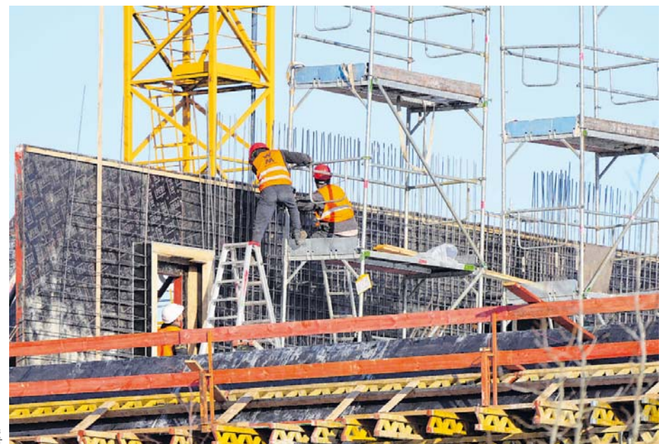
Auf der Baustelle: Höhere Lohn- und Materialkosten machen Bauprojekte unprofitabler.
